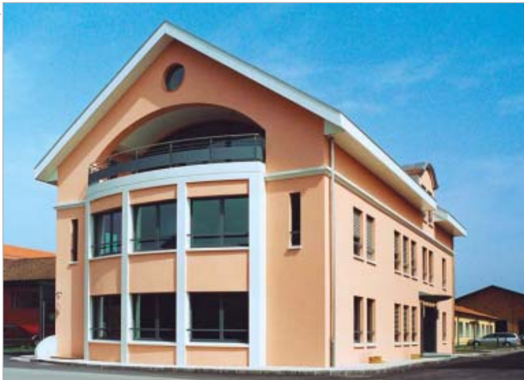
Bâtiment situé au centre du site principal de Corcelles
