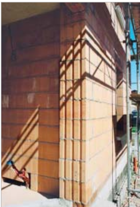
Détail de construction - Brique Ambiotherm
