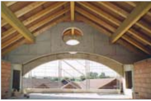
Combles en travaux...
